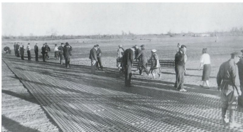
Фото 4. Укладка взлётно-посадочной полосы металлическими блоками. 1944 г.
