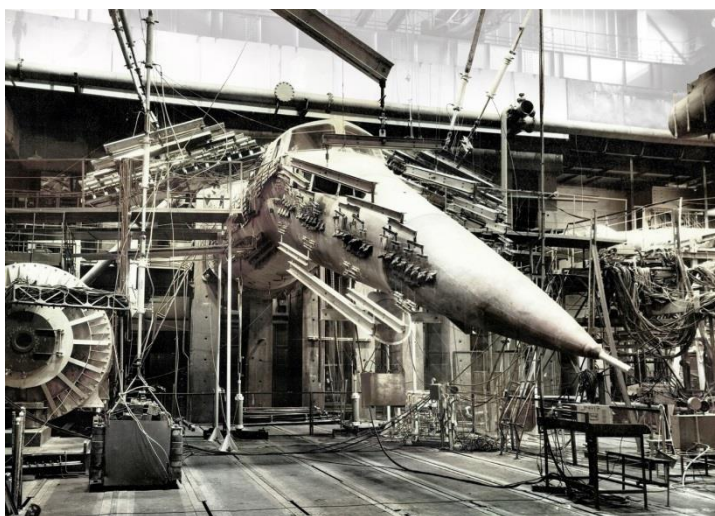
Статические испытания самолёта Ту-144
