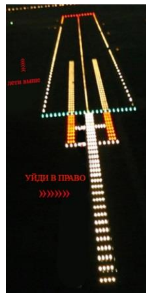
Рис 1. Огни подхода с дополнительными огнями при заходе на посадку по линии ВПП
