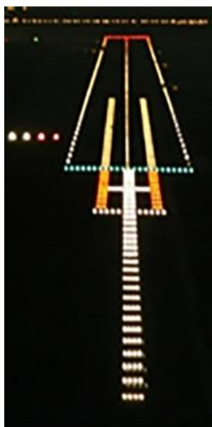
Рис 1. Огни подхода с дополнительными огнями при заходе на посадку по линии ВПП
