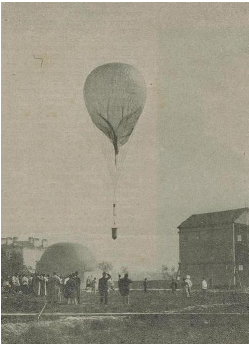
Подъём шара с метеорологическими самопишущими приборами
